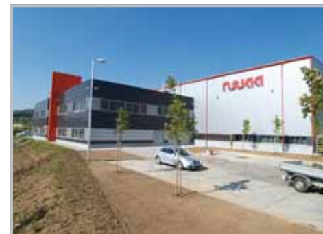
Ruukin tehdas Jászberényssä, joka sijaitsee noin 90 km päässä Budapestista. Ruukki valmistaa hitsattuja ja koneistettuja komponentteja konepajateollisuuteen. Kuva: Ruukki.
